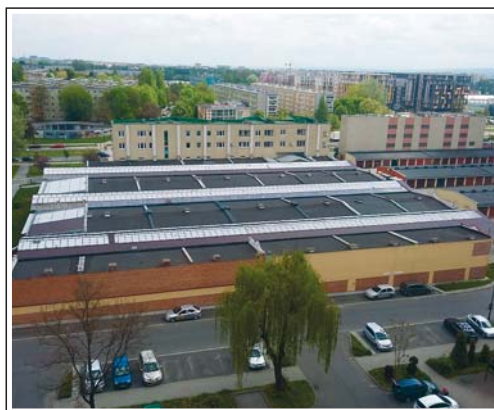
Wykonanie wymiany pokrycia dachu – garaże piętrowe ul. M. Dąbrowskiej
