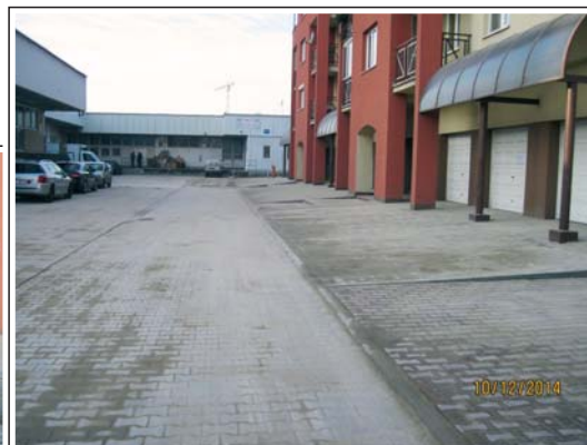
Wykonanie remontu drogi - os. 2 Pułku Lotniczego
