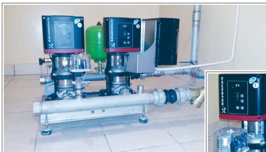
Wykonanie hydroforni budynkowych - os. Dywizjonu 303 bud. nr 40
