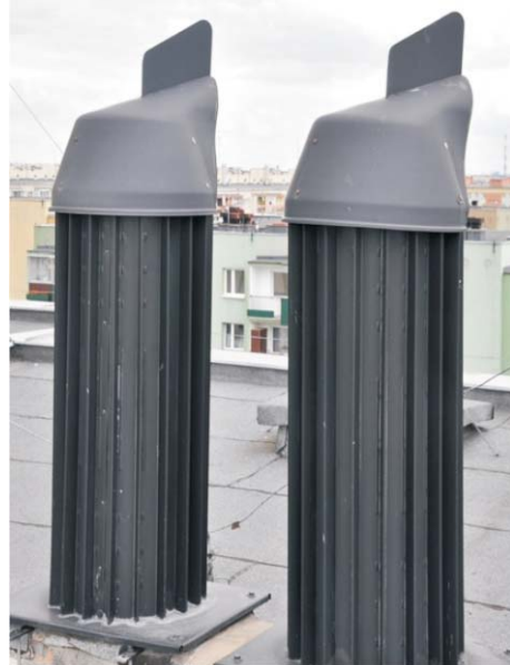
Montaż nasad kominowych
