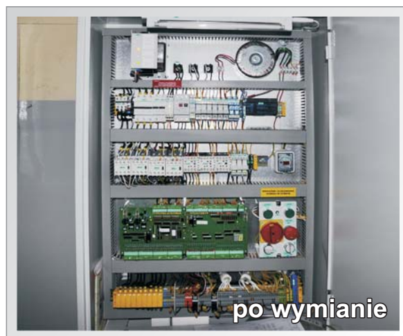
Remonty dźwigów: wymiana aparatury sterowej bud. nr 13 w os. 2 Pułku Lotniczego
