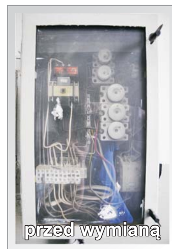
Remonty dźwigów: wymiana aparatury sterowej bud. nr 13 w os. 2 Pułku Lotniczego
