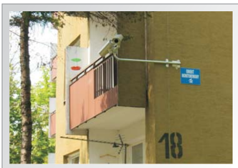
Montaż systemu monitoringu - bud. nr 18 w os. Dywizjonu 303
